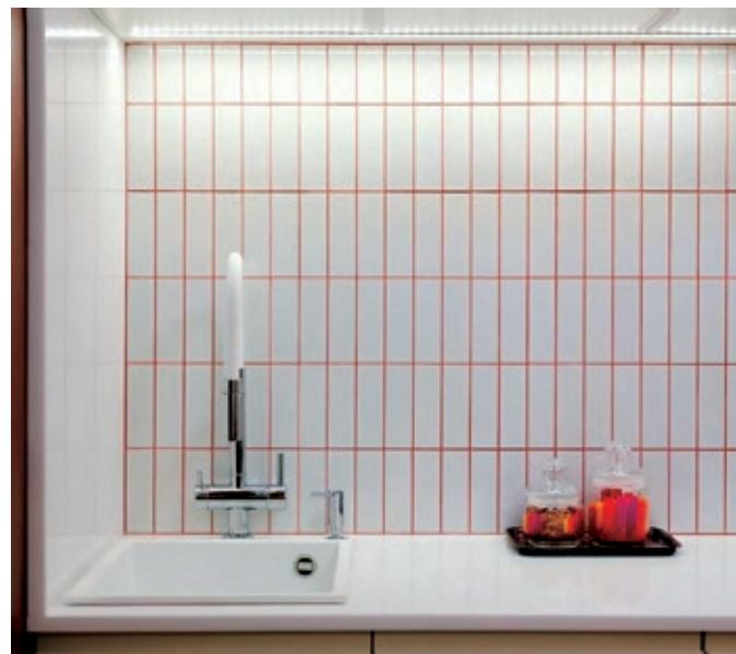
fuga), navodi sljedeće: 'Polaganje pločica bez fuga nije dopušteno. Ni u kojem slučaju ne smiju se specificirati ni usvojiti širine fuga manje od 2 mm'. Širina fuga mora se definirati tijekom faze projektiranja uzimajući u obzir sljedeće aspekte:
