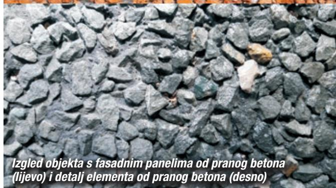
Izgled objekta s fasadnim panelima od pranog betona (lijevo) i detalj elementa od pranog betona (desno)
