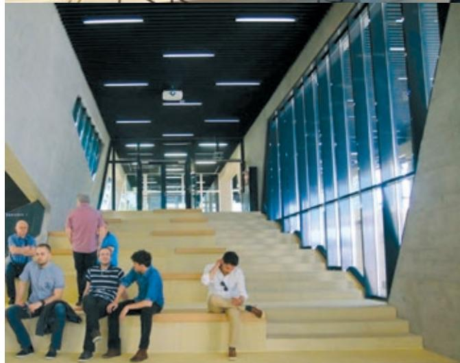
Stepenište od pranog betona (lijevo) i unutarnje stepenište od brušenog žutog betona na GF Sveučilišta u Osijeku
