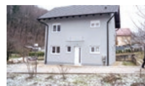
Gradnja zamjenskih obiteljskih kuća
