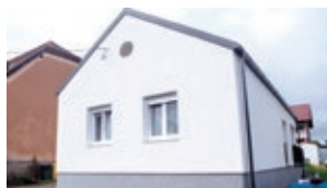
Gradnja zamjenskih obiteljskih kuća
