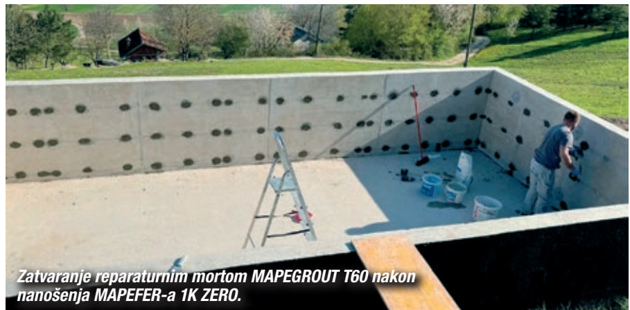
MAPEFER 1K ZERO korišten je u bazenu na Kalniku.
