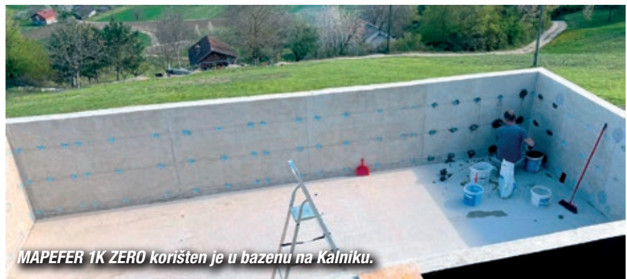
Priprema bazenske školjke – spojevi zid-zid i pod-zid zabrtvljeni su trakom MAPEBAND EASY i MAPELASTIC-om ZERO, dok su prodori bazenske tehnike zabrtvljeni ADESILEX-om PG4.
