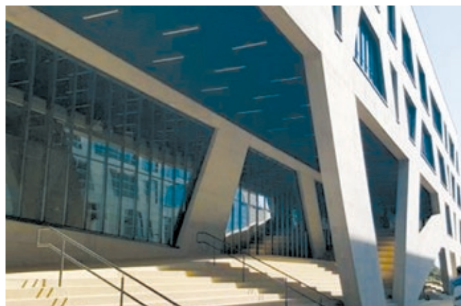
Izgled objekta s fasadnim panelima od pranog betona (lijevo) i detalj elementa od pranog betona (desno)
