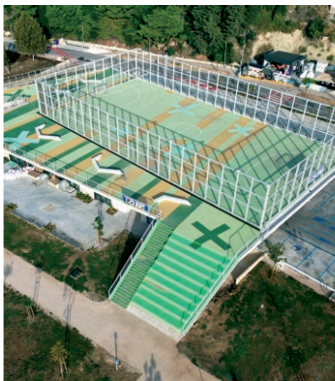
Izvođenje slojeva akrilnog višenamjenskog sustava MULTISPORT COMFORT.
